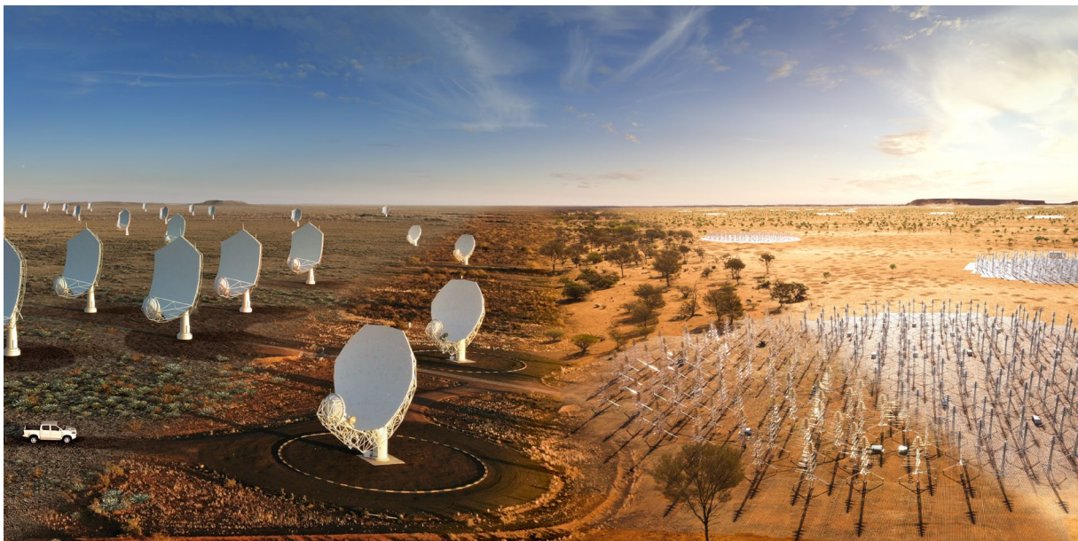
Abb. 2: Künstlerische Darstellung der SKA-Antennen. Links: für mittlere Frequenzen (SKA-MID, Südafrika); rechts: für niedrige Frequenzen (SKA-LOW, Australien).
